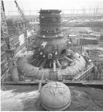
Abb. 31: Reaktor im Bau
