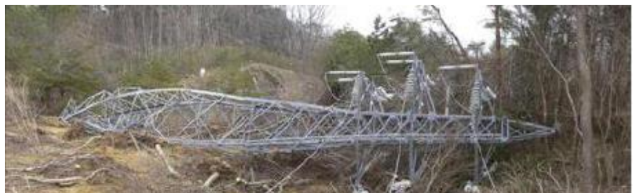
Abb. 8 – Umgestürzter Hochspannungsmast
